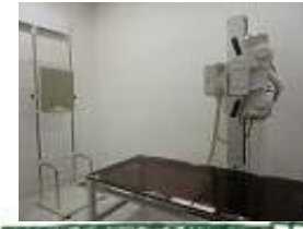
レントゲン室
